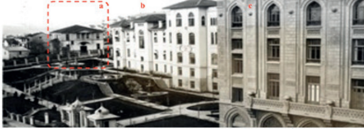
a. I.Postane Yapısı b. Maliye Vekaleti c. İş Bankası
